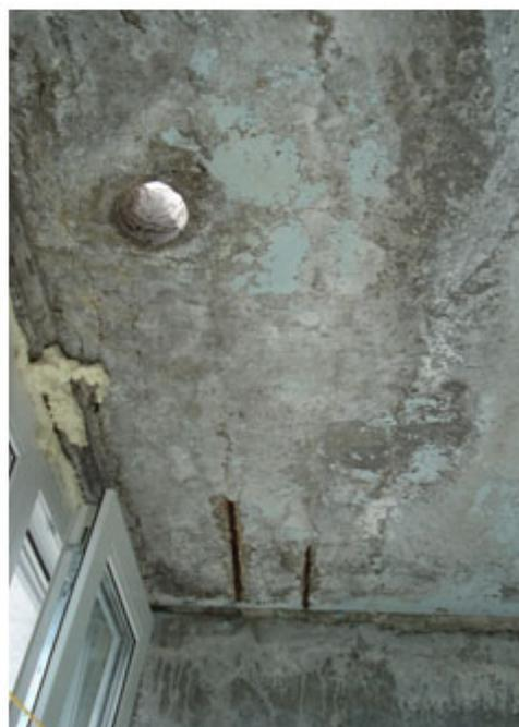
Одной из главных причин повреждения и раннего отказа железобетонных конструкций является коррозия бетона и арматуры, возникающая в результате воздействия воды, выхлопных газов, агрессивных «кислотных дождей».
